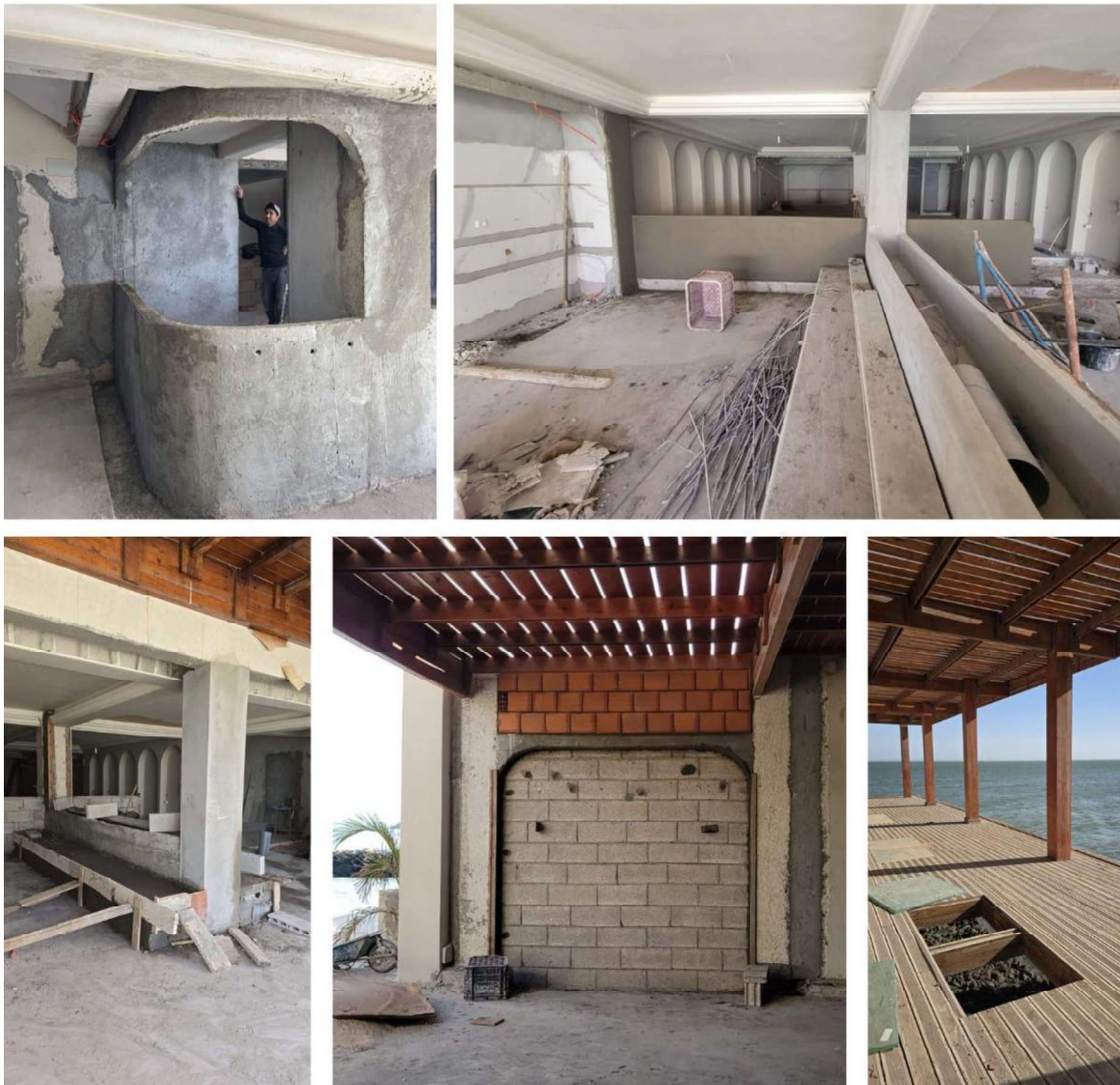
Figura 160- Imagens das obras; Fonte: In Out Studio
