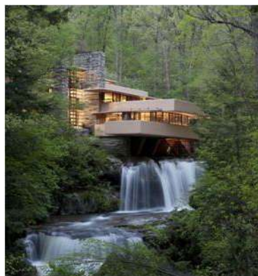
Figura 5- Fallingwater; Fonte; Fonte: franklloywright
