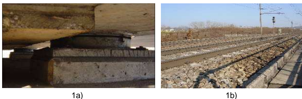
Figura 2. a) Apoios das pontes; b) Vistas das vias-férreas sobre uma das Pontes.
