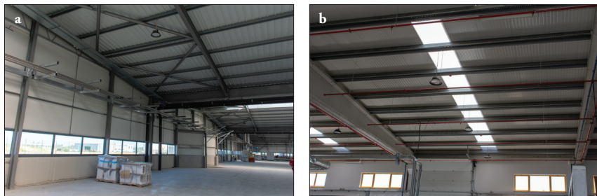
Fot. 5 - Edifícios reconstruídos: a) estrutura em aço; b) estrutura em betão pré-fabricado (Fotografias do acervo do projeto, tiradas em julho de 2020).
