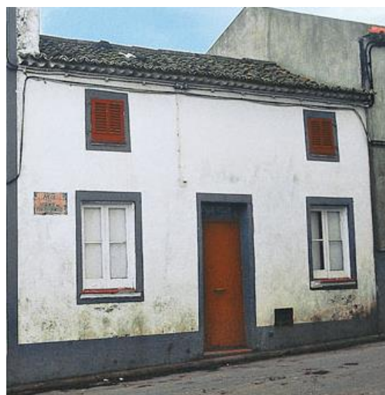
Figura 22 - Fachada com tipologia Janela-Porta-Janela. Fonte: Registo Patrimônio Regional
