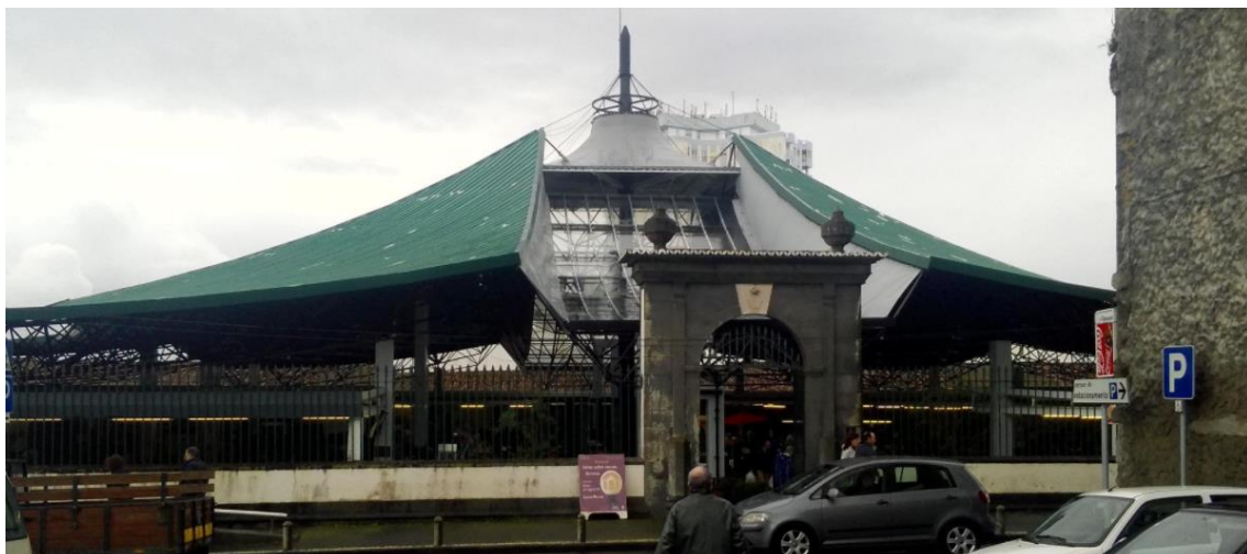
Figura 199 - Cobertura existente do Mercado da Graça. Fonte: Biblioteca Digital M-arquitectos
