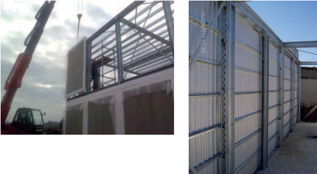
Figura 7. Paredes: a) montagem; b) aplicadas em obra
