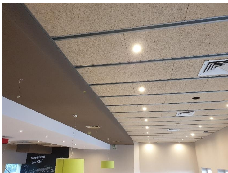
Figura 83 - Pormenor de estruturas do teto.
