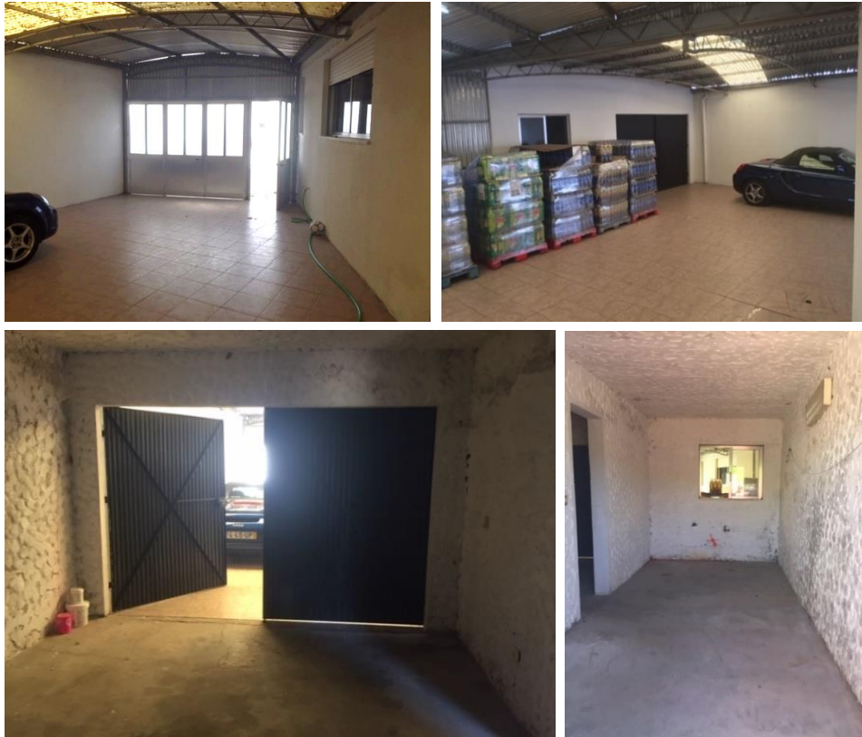
Figura 47 - Fotografias do espaço existente.
