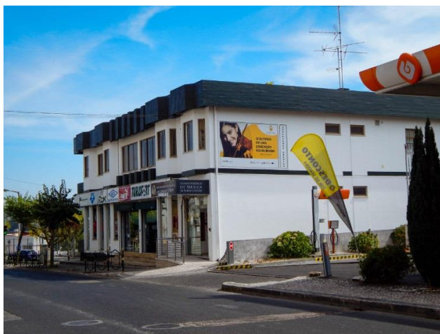
Figura 1 - Instalações do CMAC em Ourém
