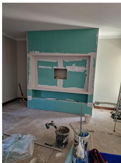
Figura 148 - Construção da parede da TV, vista de frente. Fonte: Sara Teixeira
