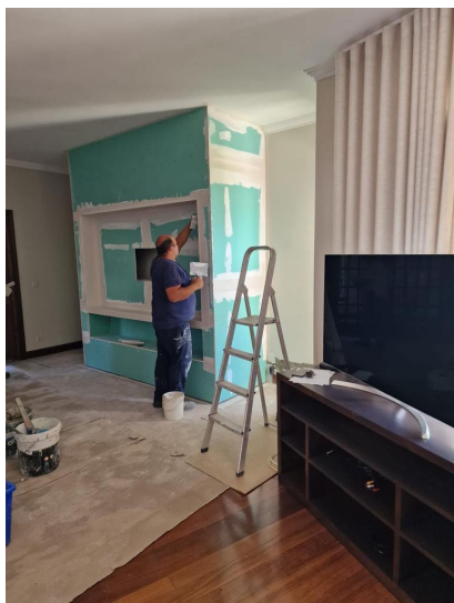
Figura 147 - Construção da parede da TV. Fonte: Sara Teixeira
