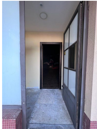
Figura 80 - Vista para entrada traseira do espaço. Fonte: Carolina Alves e Débora Pina
