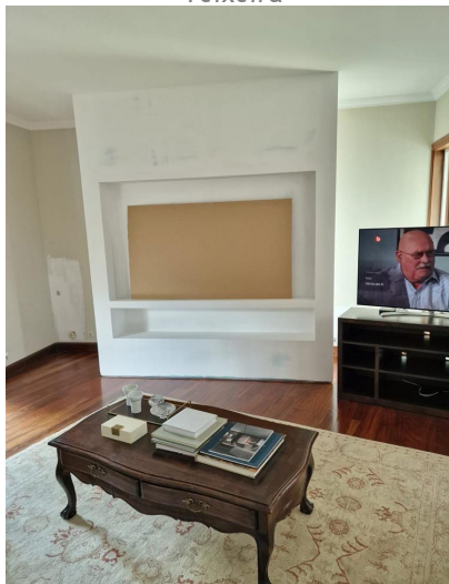
Figura 150 - Parede da TV finalizada, vista de frente. Fonte: Sara Teixeira
