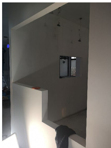
Figura 96 - Balcão da receção com vista para o lado esquerdo. Fonte: Débora Pina
