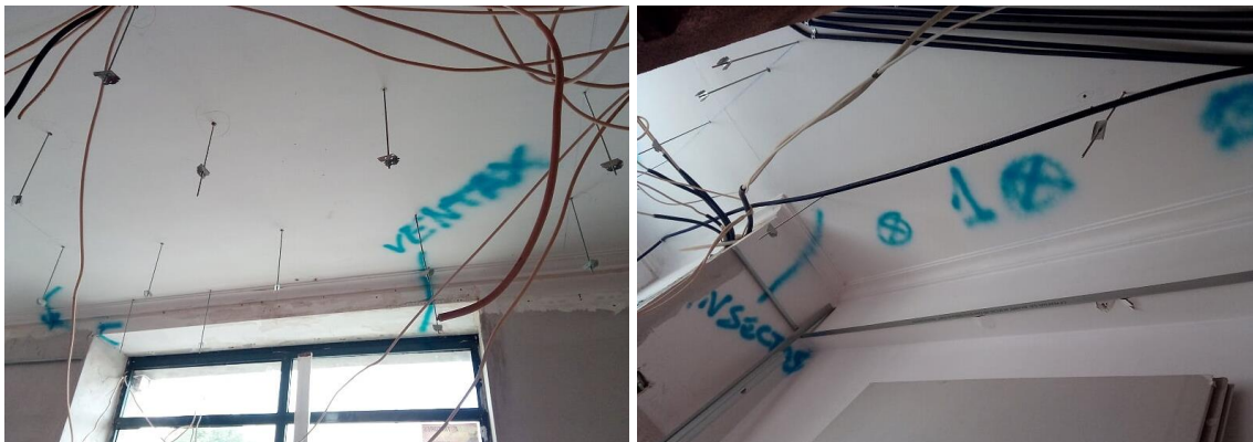
Figura 355 e 356 - Fotografias do espaço onde é possível ver com mais pormenor os perfis para a aplicação do teto falso, e as demarcações para criação de pontos de luz
