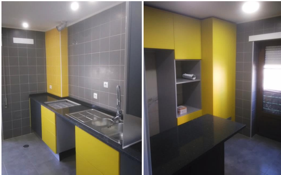
Figura 106 e 107 - Espaço da cozinha concluído
