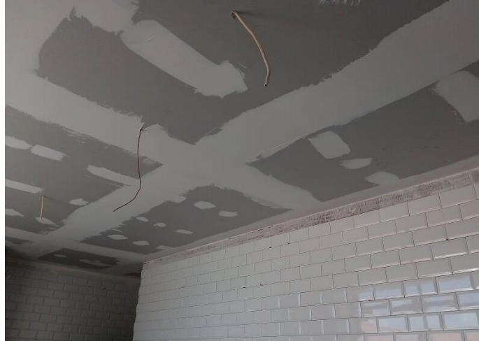
Figura 357 - Pormenor do revestimento cerâmico aplicado e do teto falso quase terminado, onde é possível ver as ligações para a colocação da iluminação
