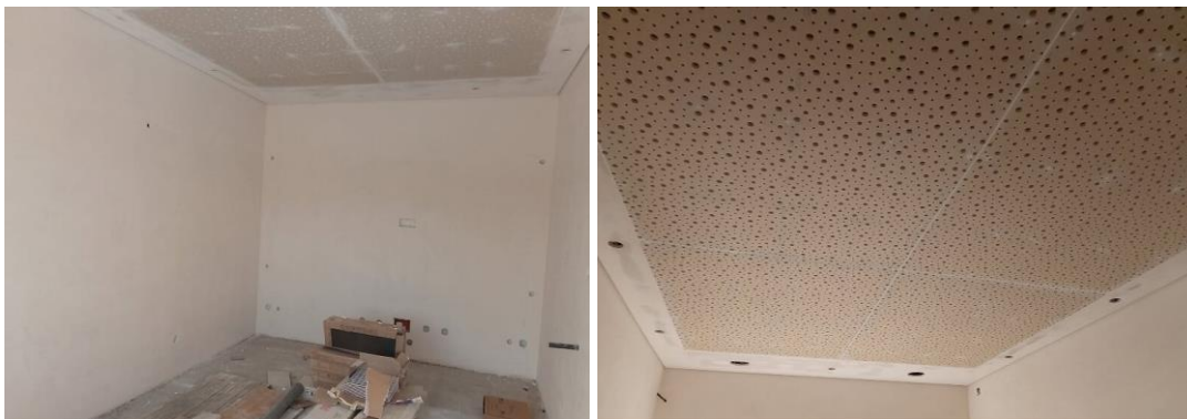
Figura 129 e 130 - Espaço da sala de cinema antes da intervenção
