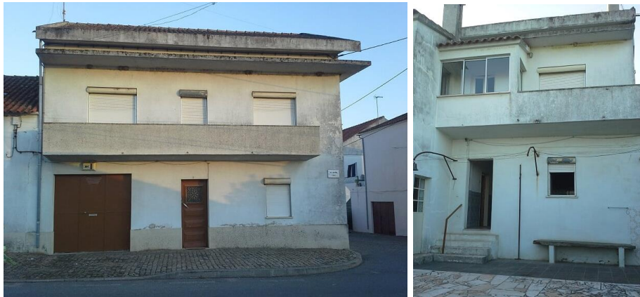
Figura 177 e 178 - Fachada e traseira da habitação, respetivamente
