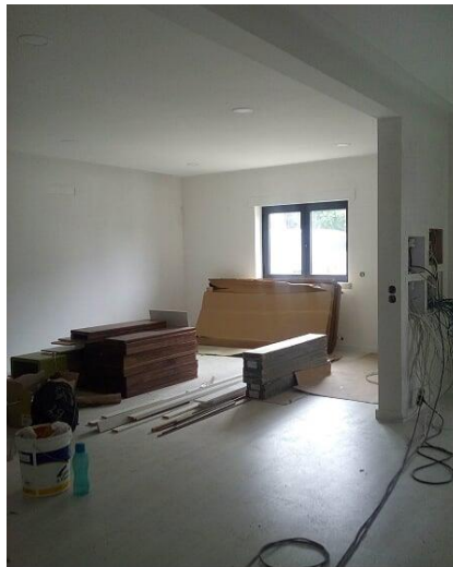
Figura 110 - Espaço da sala antes da intervenção
