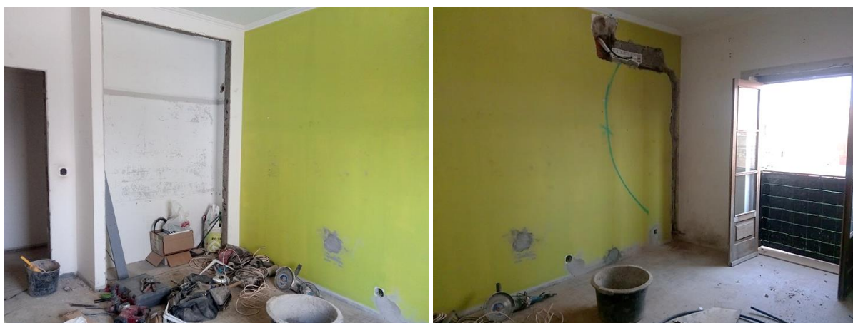
Figura 93 e 94 - Processo de obra do quarto de menina
