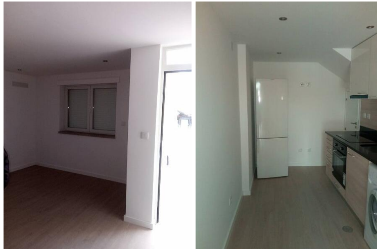
Figura 53 e 54 - Espaço antes da intervenção
