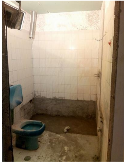
Figura 98 - Processo de obra do quarto de casa de banho
