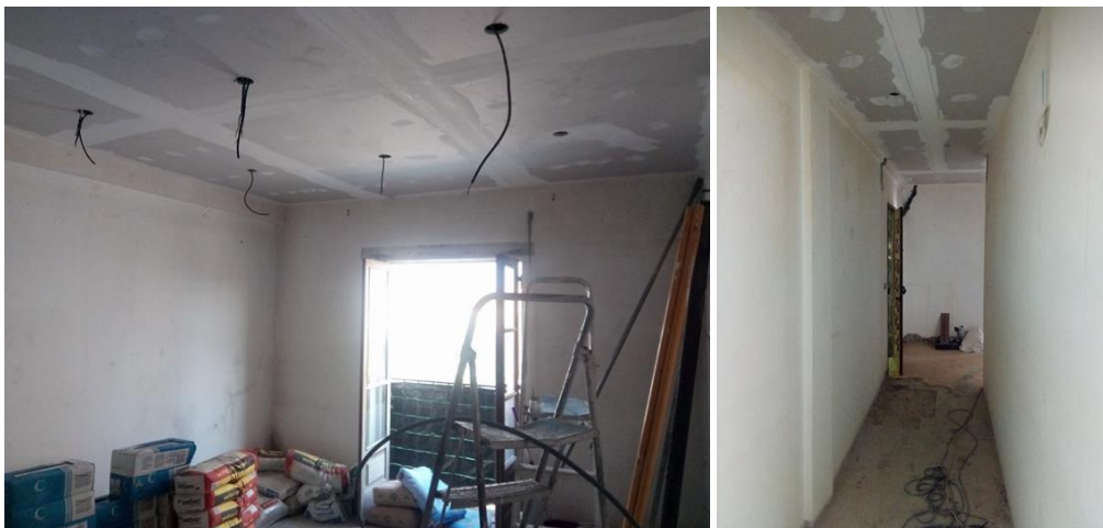
Figura 89 e 90 - Processo de obra da sala e corredor, respetivamente, onde é possível ver o teto falso e as ligações para a iluminação, assim como no corredor
