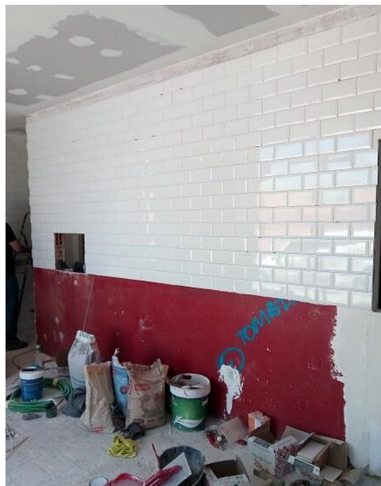
Figura 358 - Parede com aplicação de revestimento cerâmico
