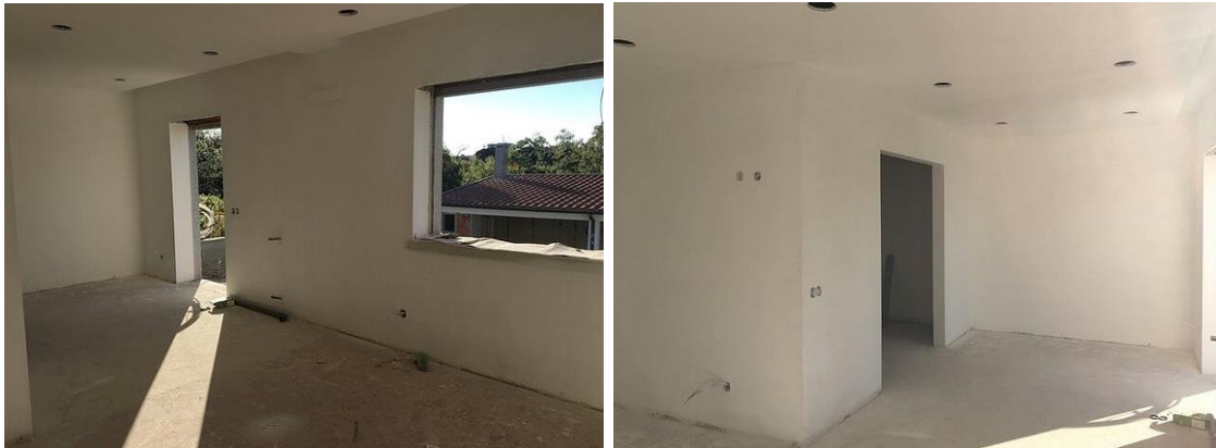
Figura 111 e 112 - Espaço da suite antes da intervenção
