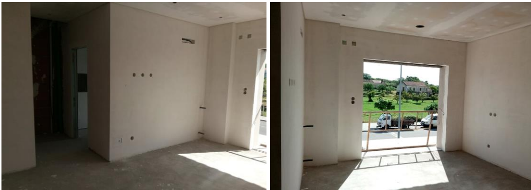
Figura 121 e 122 - Espaço da suite antes da intervenção
