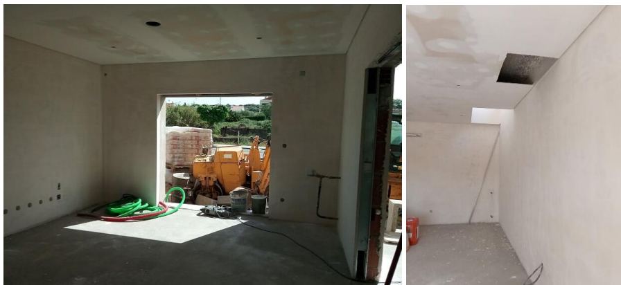
Figura 127 e 128 - Espaço da sala antes da intervenção
