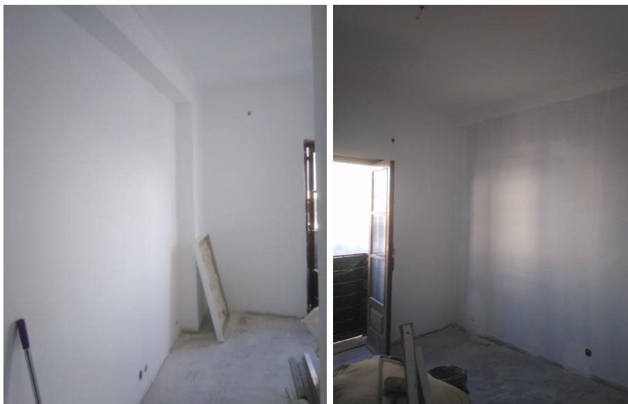
Figura 91 e 92 - Processo de obra do quarto de casal
