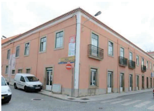
Figura 2 - Fotografia do edifício Centro Infantil Adriano Godinho
