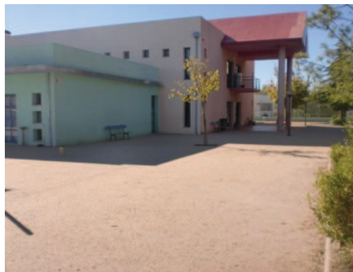
Figura 18 - Espaço exterior da EB de São Tiago.
