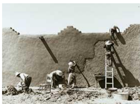
Figura 118 – Aplicação do adobe, como revestimento
