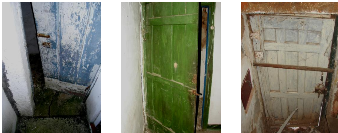
Figuras 143, 144 e 145 – Imagens das diferentes tipologias de portas existentes na habitação
