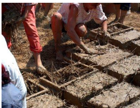
Figura 117 – Bloco de terra comprimido á mão
