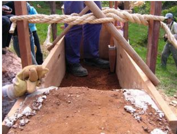
Figura 122 – Preparação da construção de uma parede feita a partir de uma técnica construtiva- A Taipa
