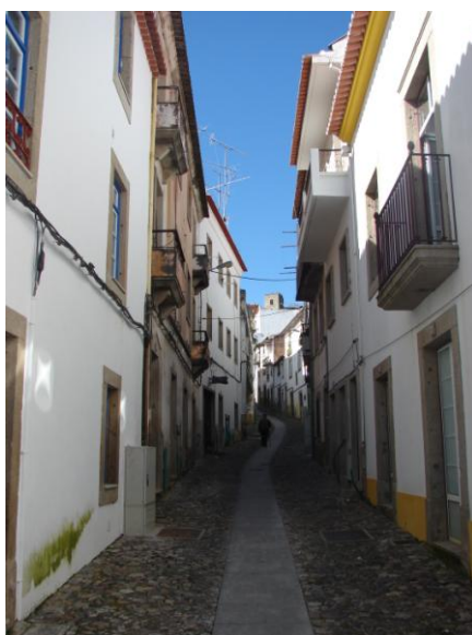
Figura 82 e 83 – Arruamentos na zona histórica
