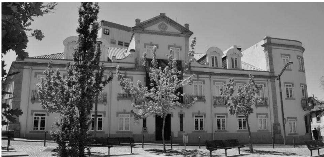
Figura 2 - Fachada do antigo Edifício dos CTT onde funciona o Gabinete de Reabilitação Socio Habitacional do Centro Histórico e da devesa de Castelo Branco.
