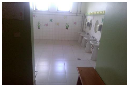
Figura 5: Instalações sanitárias - sanitas
