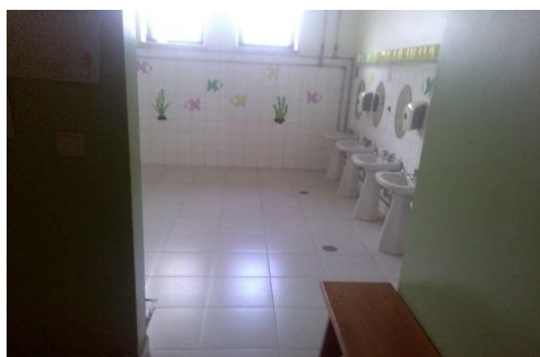
Figura 4: Instalações sanitárias - lavatórios
