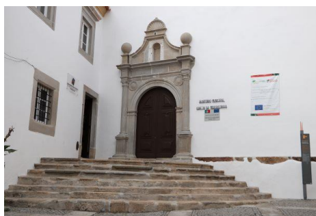
Figura 3 - Edifício da EANA, imagem retirada EANA, 2018-2021
