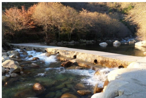
Foto 8 - Troço 3: Pontão Senhor dos Aflitos
