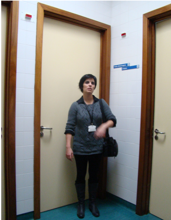
Figura 95: Sinalética colocada demasiado alta no Departamento de Psiquiatria e Saúde Mental da Covilhã. (Fonte: Ana Malta)
