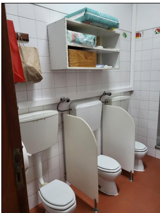
Figura 7 - Casa de banho
