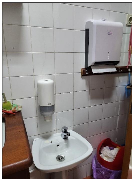
Figura 8 – Lavabos da Casa de banho
