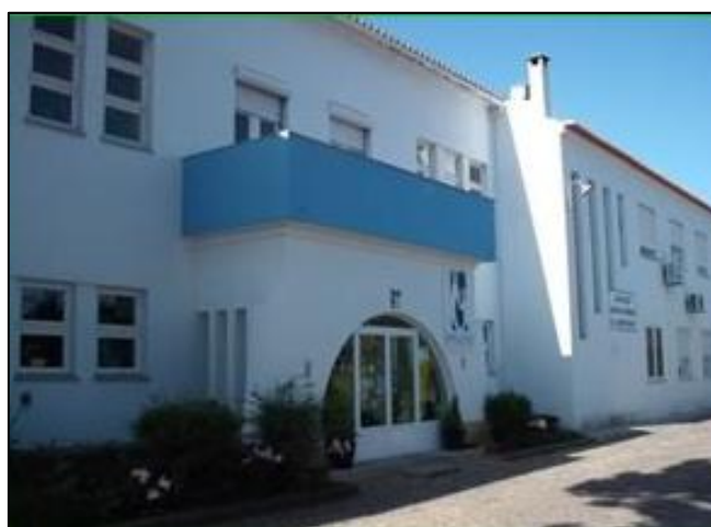
Figura 2 – Fachada da Instituição Dr. Alfredo Mota
