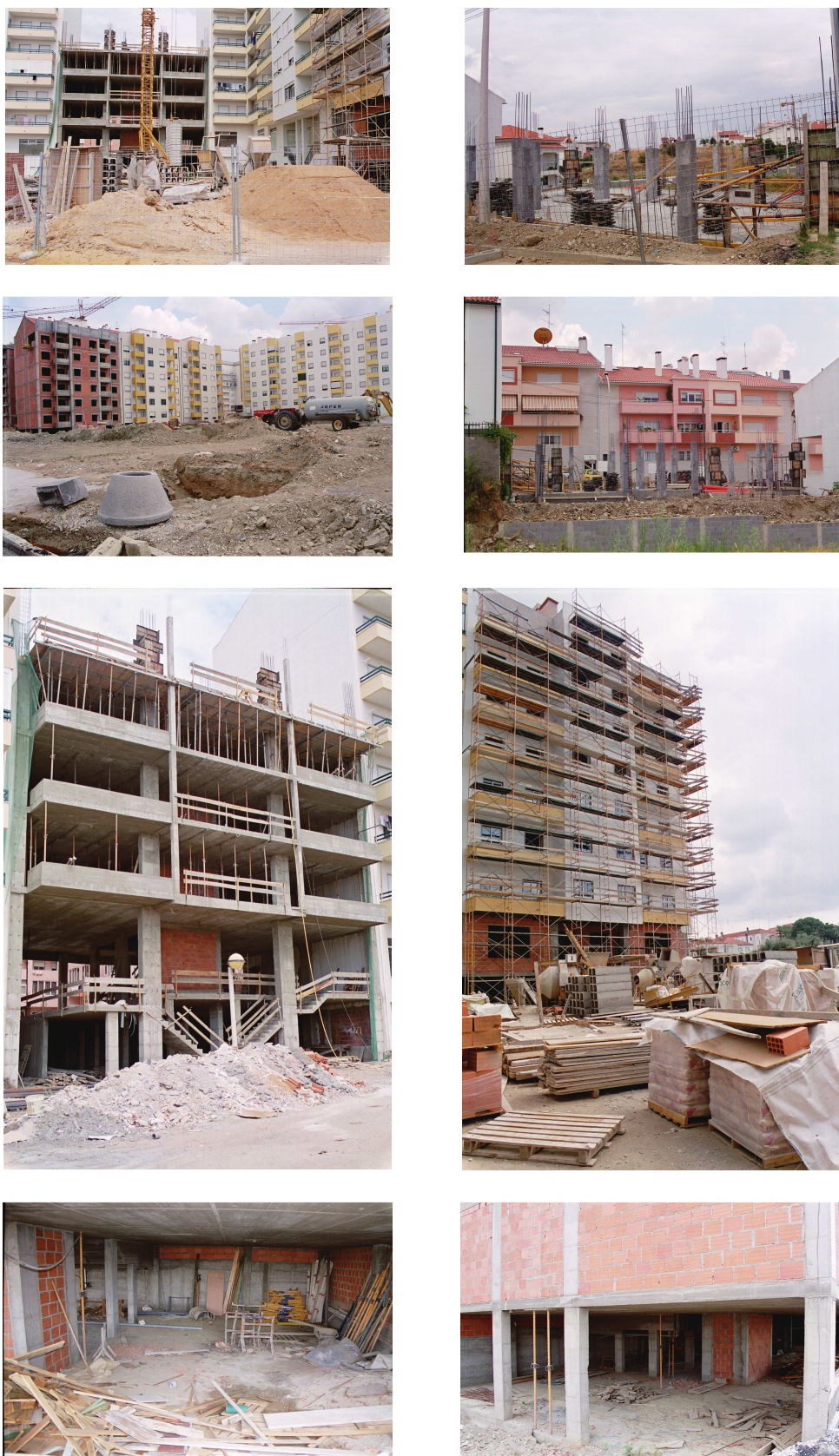
Figura 4.1. Estaleiros e respectivas obras. É óbvia a impossibilidade de actuação de robôs.
