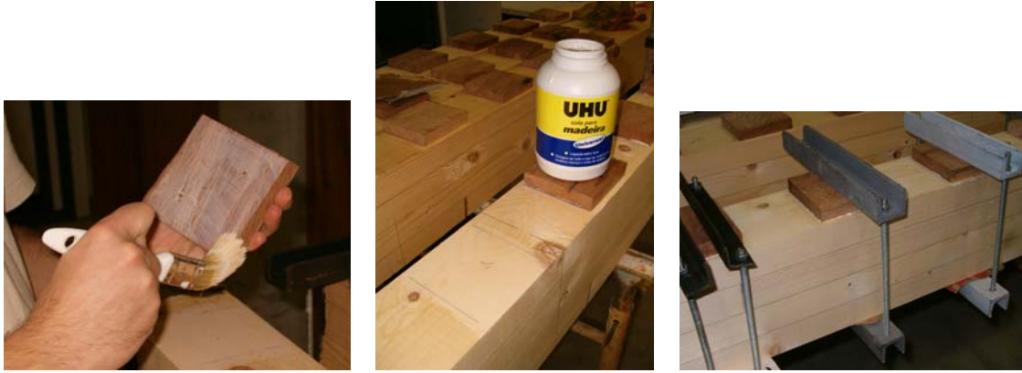
Figura 74 – Preparação da ligação por tacos colados na viga mista.
