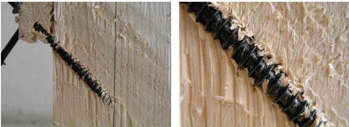
Figura 37 – Modo de rotura por arrancamento.
