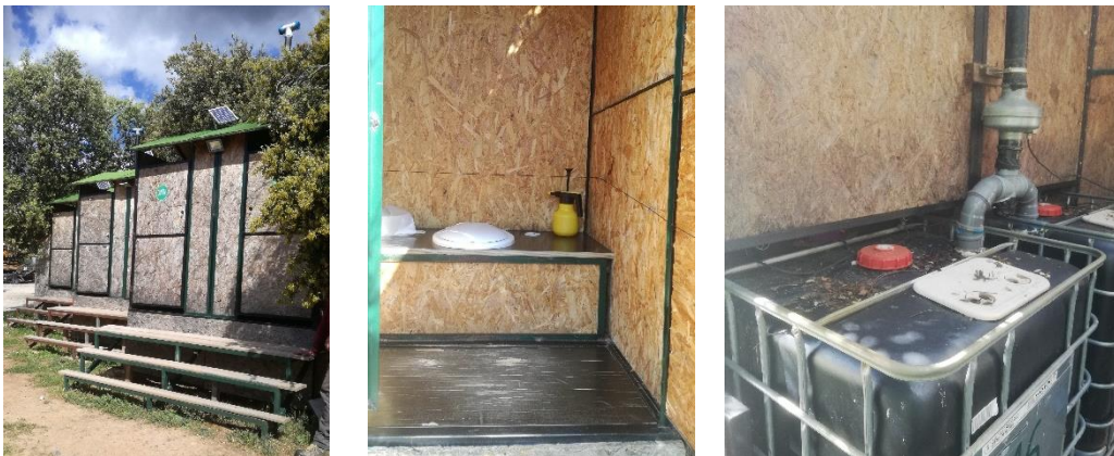
Figuras 205, 206 e 207 - Instalações sanitárias construídas no Boom Festival; o seu interior e os depósitos de compostagem
