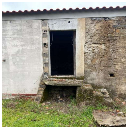
Figura 69 - Fotografia do exterior da moradia para alojamento rural, fachada lateral, pormenor de entrada de serviço com acesso de escadas. Fonte: Autor
