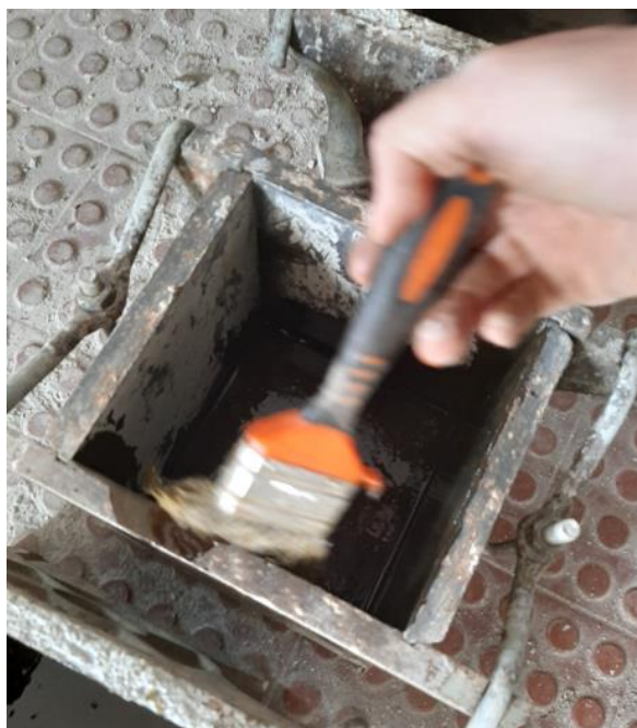
Figura 44 - Aplicação do óleo descofrante
