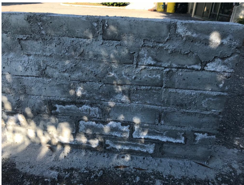
Figura 81 - Parede de tijolo de solo-cimento
