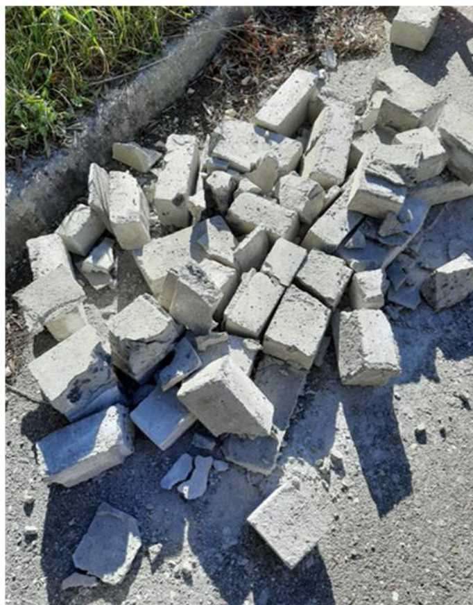
Figura 77 - Muro de tijolos de solo-cimento após demolição
