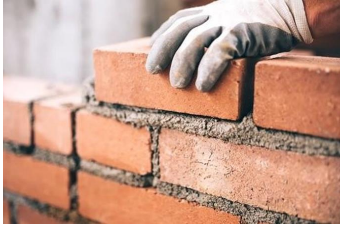
Figura 80 - Parede de tijolo cerâmico [30]
