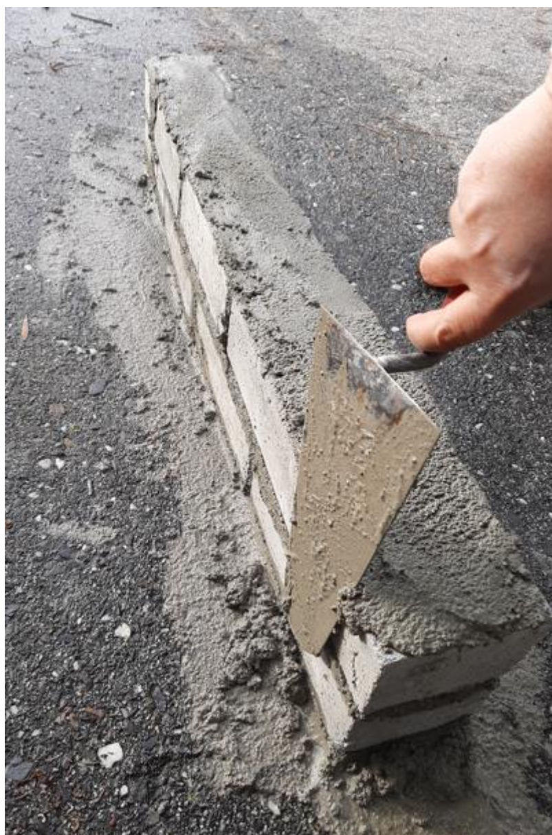
Figura 56 - Construção do protótipo de muro
