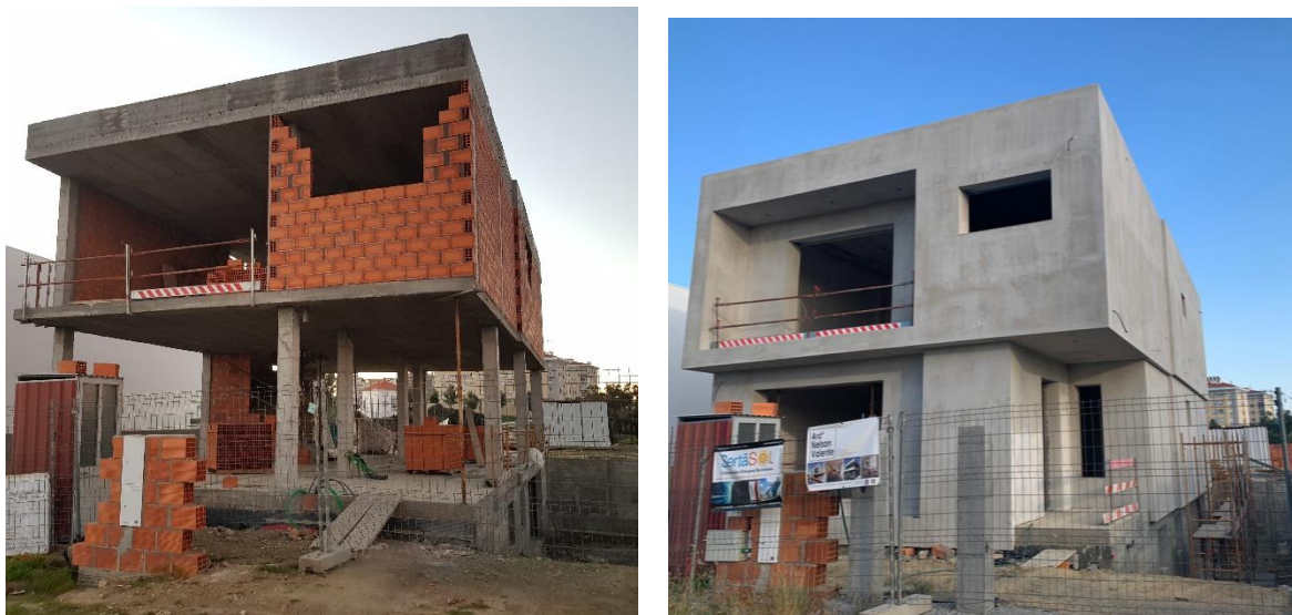
Figura 61 - Imagens do avanço da obra. Fonte: GANV
