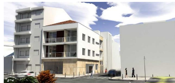
Figura 8 - Edifício 3 Globos- [Imagem 3D]. Fonte: Website do GANV
