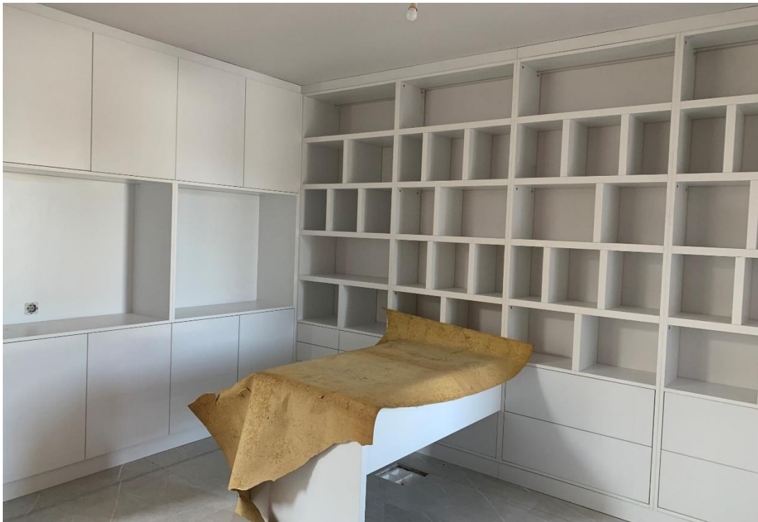
Figura 63 - Imagens finais da obra, escritório. Fonte: GANV
