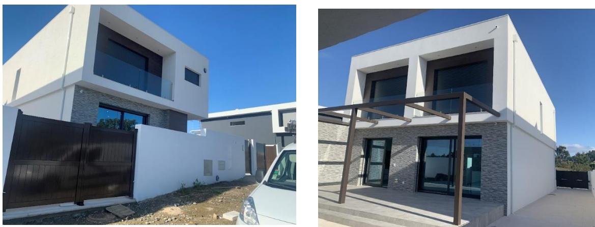
Figura 62 - Imagens finais da obra. Fonte: GANV
