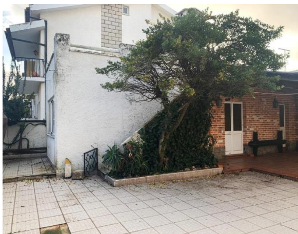
Figura 81 - Moradia, vista posterior [fotografia]. Fonte: autor
