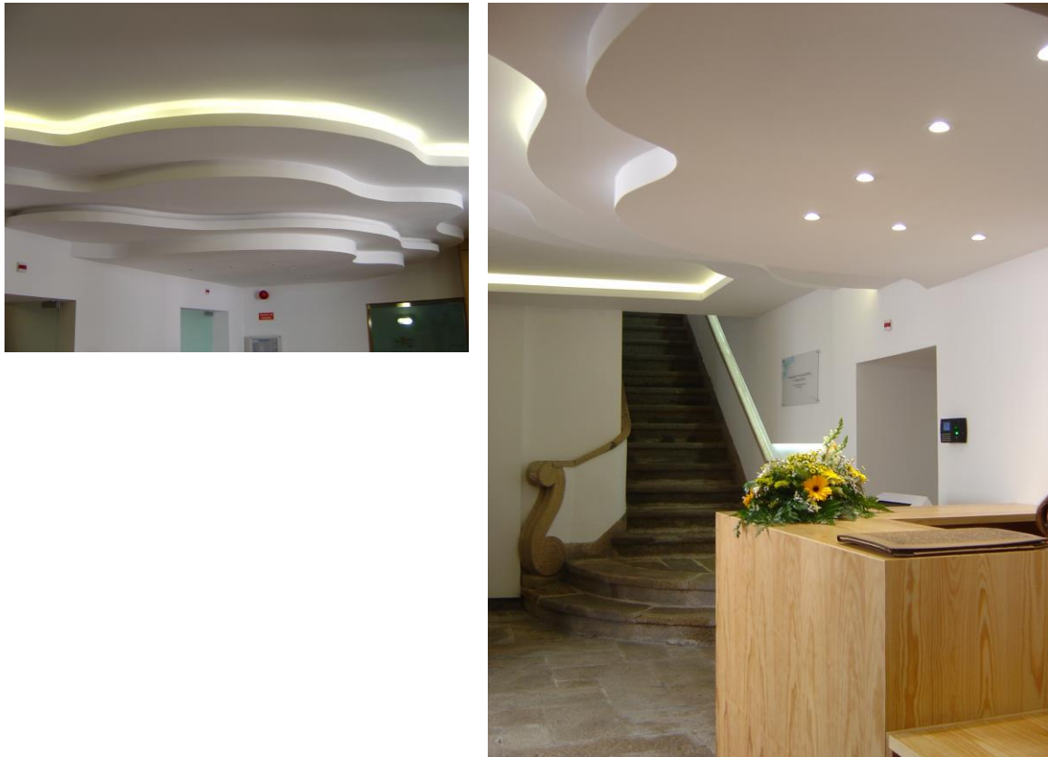
Figura 50 – Registo fotográfico do teto proposto finalizado. Fonte: Arquiteta Ana Luísa
