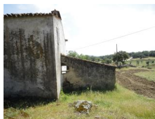
Figura 15 - Santinho – Estrada da Serra – U.F. de Reguengo e São Julião – Portalegre. Fonte: Biblioteca de Projetos do atelier.
