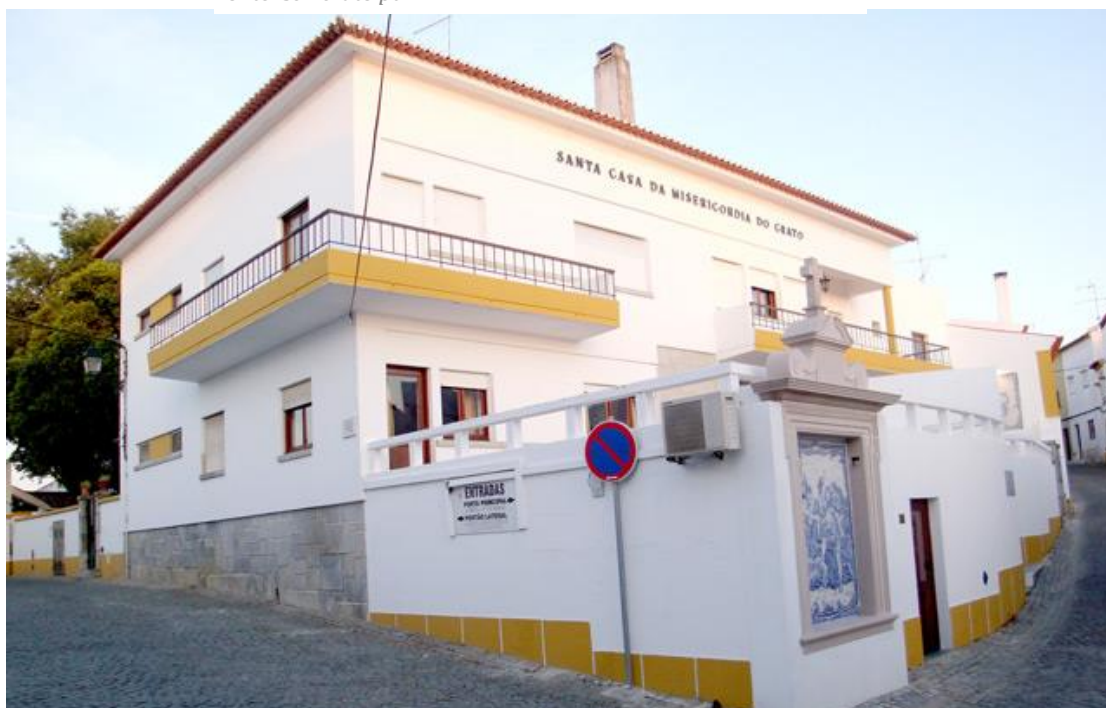
Figura 73 – Registo fotográfico do edifício da Santa Casa da Misericórdia do Crato. Fonte: scmcrato.pt
