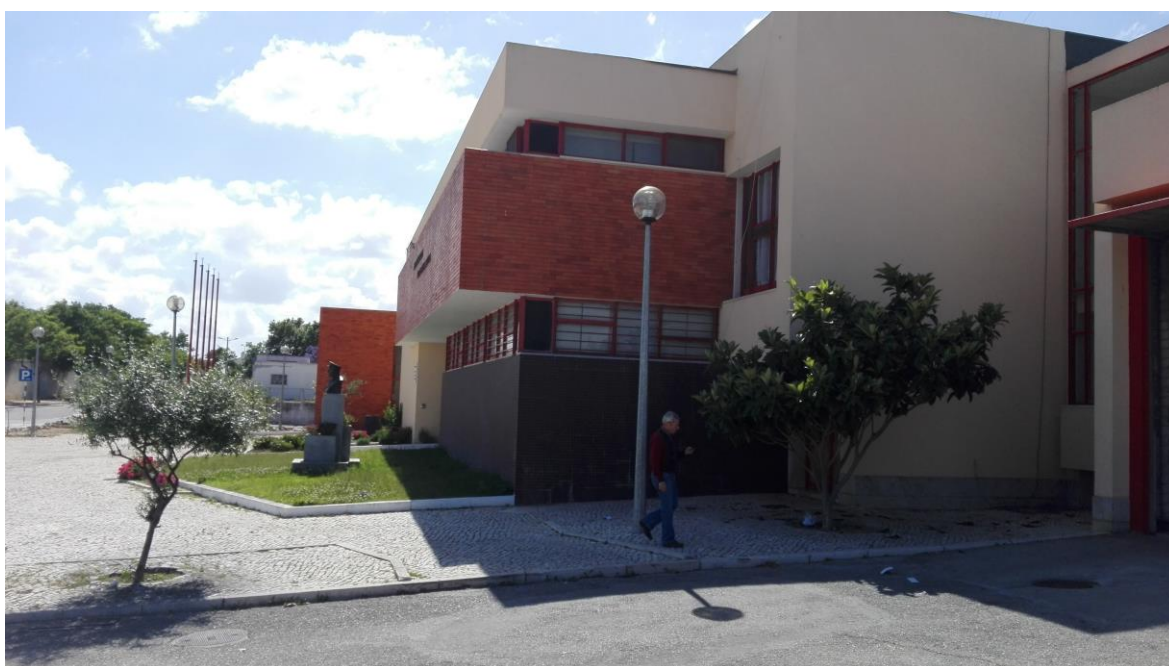
Figura 40 – Registo fotográfico do Quartel dos Bombeiros Voluntários do Montijo. Fonte: Biblioteca de projetos do atelier.
