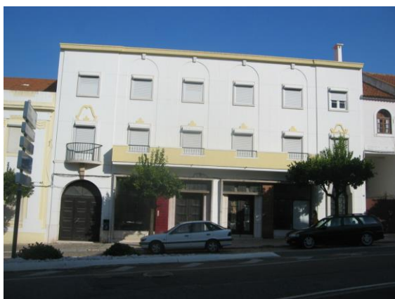
Figura 38 - Registo fotográfico da fachada existente do Edifício Piriquito – Santiago do Cacém. Fonte: Biblioteca de projetos do atelier.
