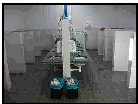
Figura 3 - Casa de banho
