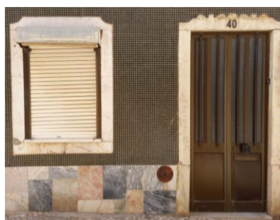
Figura 33 Caixilharia em alumínio com cantaria de pedra mármore. Fonte: Autor
