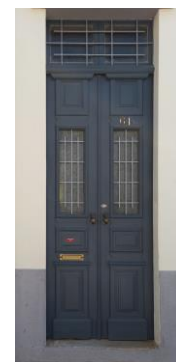
Figura 29 Vão em madeira tratada. Fonte: Autor
