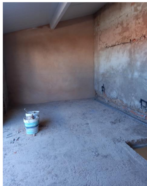
Figura 66 Sinalização de tomadas para as mesas de cabeceira. Fonte: Atelier Studio Arte
