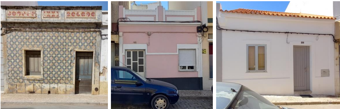
Figura 15 Fachadas "Porta-Janela". Fonte: Autor
