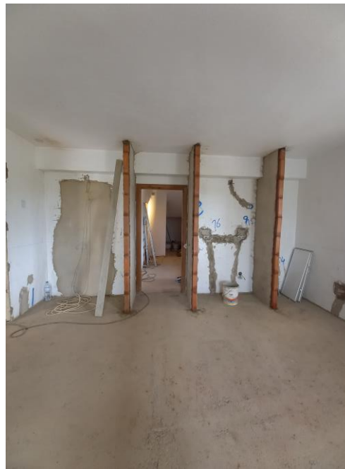
Figura 69 Local da cozinha. Parede das divisórias já executadas. Fonte: Atelier Studio Arte
