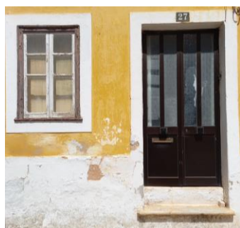
Figura 32 Porta em alumínio e Janela em madeira. Fonte: Autor
