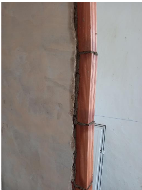
Figura 70 Local da cozinha. Parede divisória com o acrescento de profundidade. Fonte: Atelier Studio Arte
