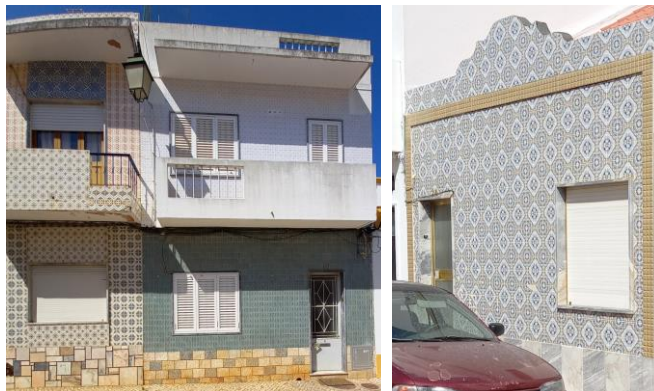
Figura 21 Fachada com revestimento cerâmico liso ou com motivos geométricos / abstratos. Fonte: Autor
