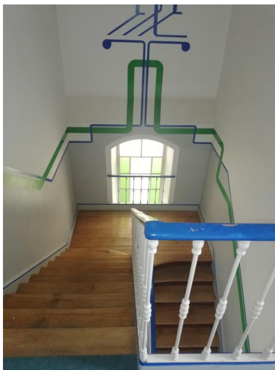
Figura 232 Escadas comuns existentes. Fonte: Atelier Studio Arte
