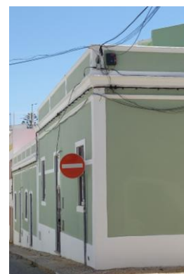
Figura 27 Remate com platibanda. Fonte: Autor
